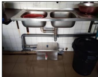
Notis PH4 Pemasangan Grease Trap
