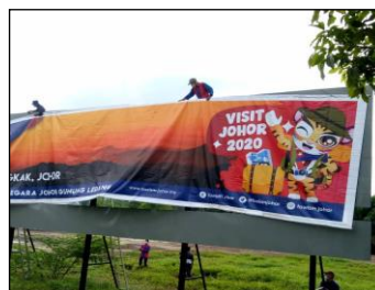
Pemasangan Bunting Dan Banner
