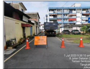
Status Tindakan Mural Kerja-kerja penyediaan tapak pada 1 - 7 Julai 2020
